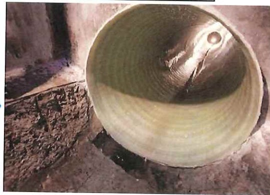
管更生施工後の下水道管
